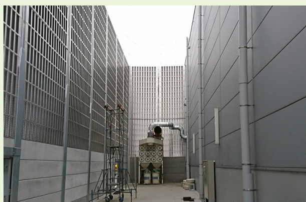
防音壁 内側から見た様子（建設中）
