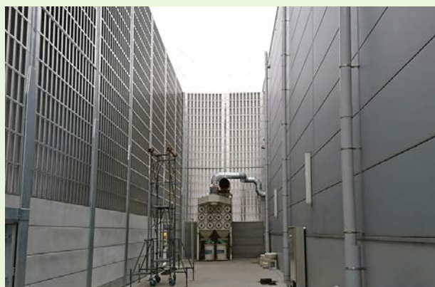
防音壁 内側から見た様子（建設当時）
