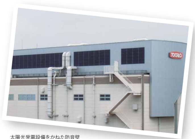
太陽光発電設備をかねた防音壁
