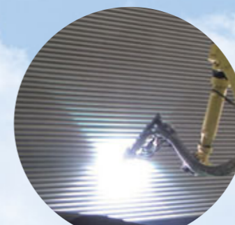
ボイラ伝熱管
