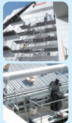
懸命の復旧作業が続きました
